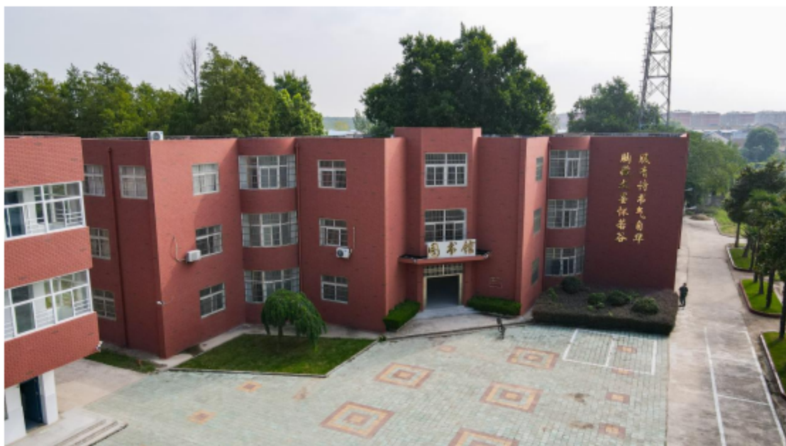
图 2 翻新后的教学楼外立面
